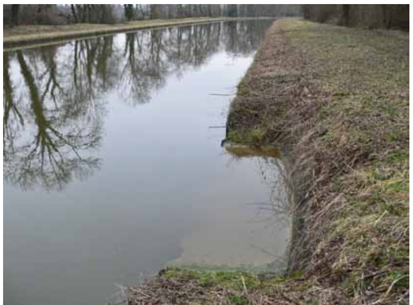
Dispositif de sortie de l'eau sur le canal du Loing, au sud de la forêt de Fontainebleau.
