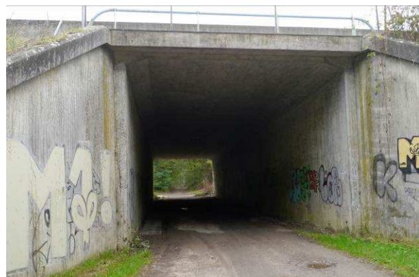
N°2/ Passage sur le chemin de Larchant. Comme le précédent, cet ouvrage est potentiellement utilisable par le sanglier, par le chevreuil, mais peu favorable au cerf. ©V. Vignon
