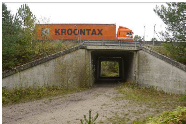
N°9/ Passage du chemin des Cassis sous l'autoroute A6. Cet ouvrage est potentiel pour le sanglier et pour le chevreuil et très peu favorable au cerf. ©V. Vignon
