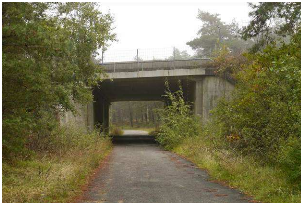
N°5/ Passage de la Route de la Plaine de la Haute Borne. Cet ouvrage est potentiel pour le sanglier et pour le chevreuil et très peu favorable au cerf. Il y a une trémie ouverte qui laisse passer le bruit de circulation dans l'ouvrage. ©V. Vignon
