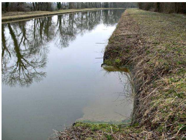
Sur la même rive un troisième type de dispositif, entaillé dans la berge. ©V. Vignon
