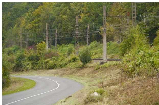
Entre Héricy et Fontaine-le-Port, la voie ferrée qui longe la Seine en rive droite sans constituer un obstacle pour les ongulés ou les carnivores. ©V. Vignon
