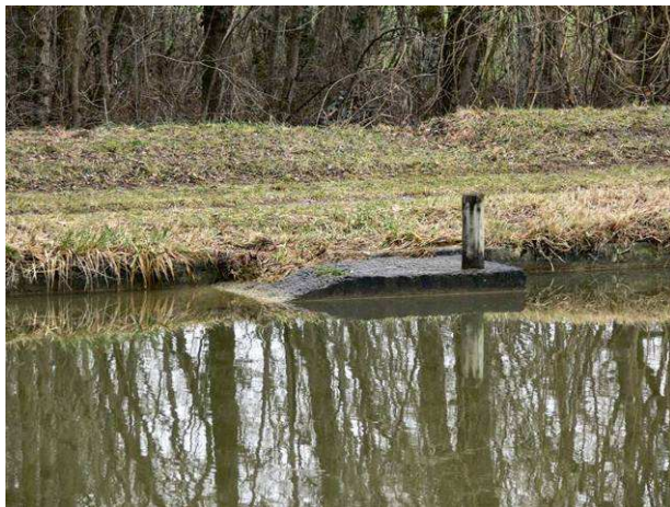
Dispositif de sortie de l'eau en béton le long du canal du Loing à Sorques. ©V. Vignon
