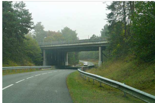
N°6/ Passage de la RD64. Lorsque le trafic est faible, la nuit, cet ouvrage est potentiel pour le sanglier et pour le chevreuil et très peu favorable au cerf. Il est contraint par la longueur des glissières disposées dans les virages aux abords de l'ouvrage. ©V. Vignon
