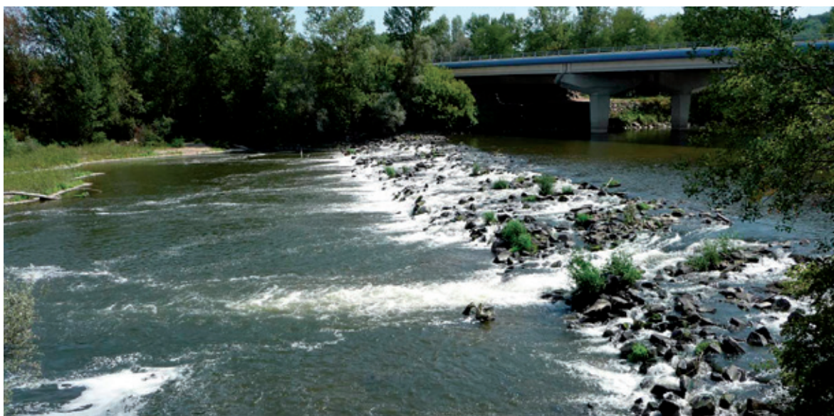
Figure 12 : Photographie du seuil A89 (ROE 63404) avant travaux. ©Vinci Autoroutes
