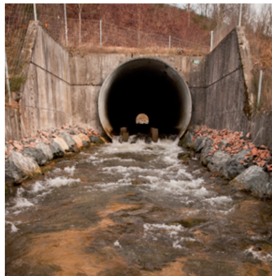
Figure 3: Dispositif hydraulique unique constitué d'une semelle rugueuse et de ralentisseurs préfabriqués.
