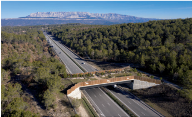
Figure 4 : Écopont de Fuveau A50. ©Photothèque VINCI Autoroutes.
