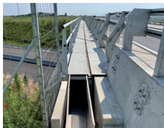
Figure 45 : Caniveau de 70 x 40 cm en alliage d'aluminium brut d'épaisseur 2 mm, fixé sur le support par des vis en inox A4. © Photothèque VINCI Autoroutes
