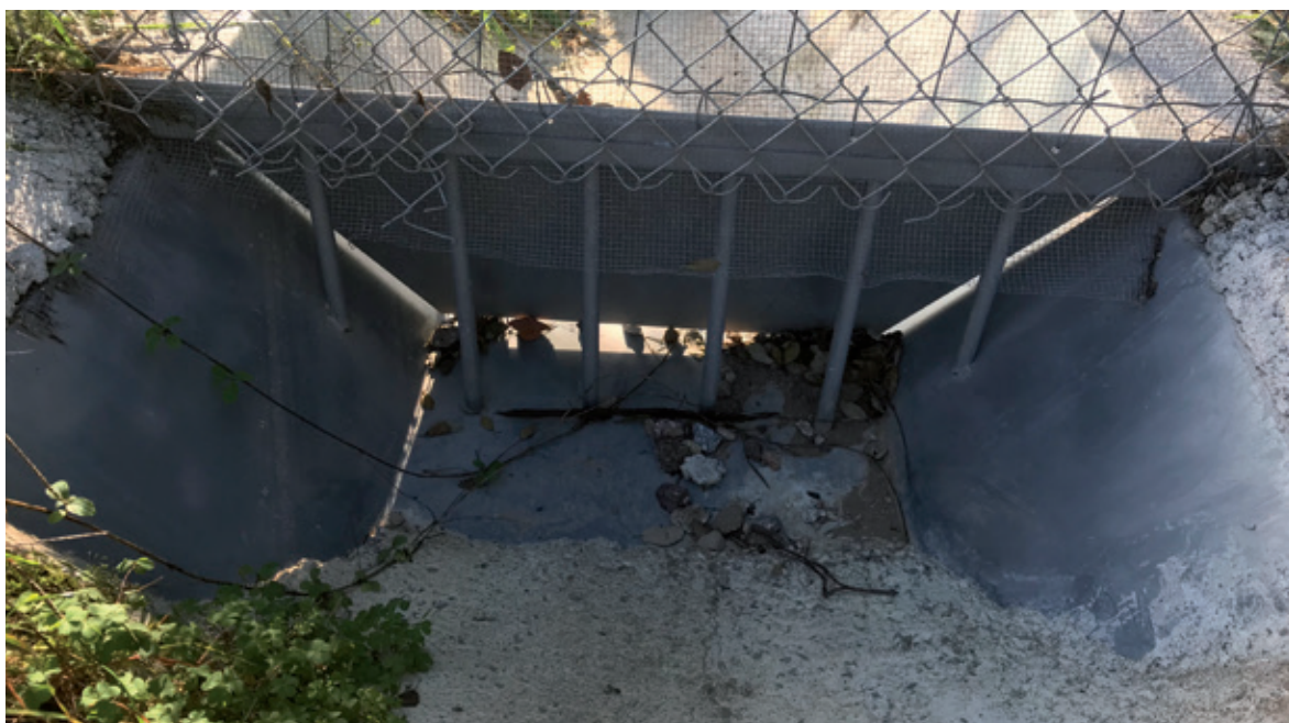
Figure 18 : Prototype de module fossé inox SANIEZ pour sécuriser les fossés en remplacement des seuils béton classiques. ©Cabinet X-AEQUO.
