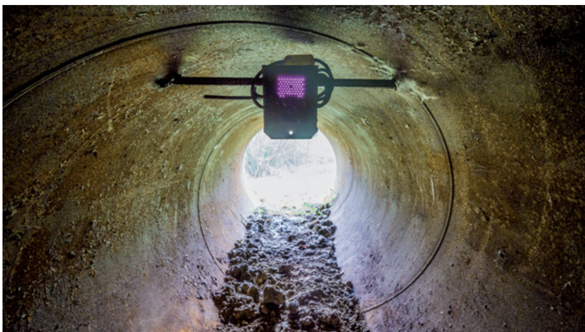
Figure 35 : Exemple d'un substrat argileux en mottes sèches dans un écoduc de 120 centimètres de diamètre. ©Alexis Orseau/LPO France.
