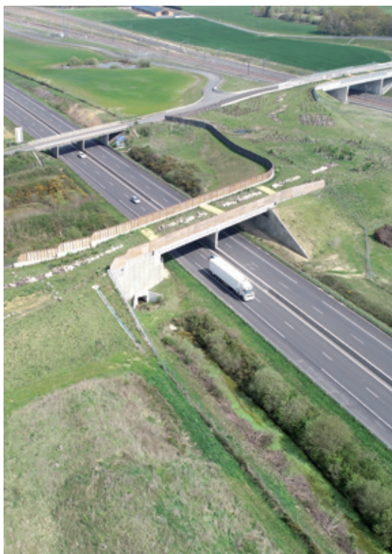
Figure 47 : Écopont Le Bas-Bry, un passage pour la faune au-dessus de deux infrastructures. ©VINCI Construction Terrassement.
