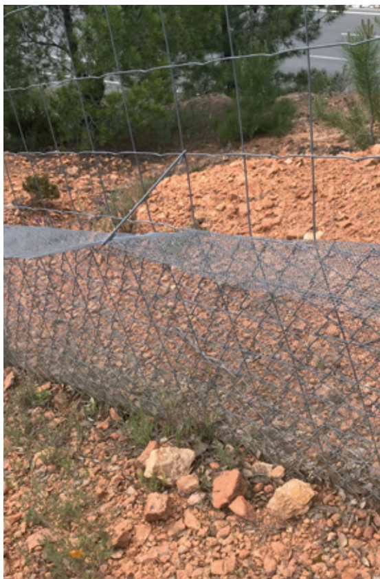
Figure 17 : Bavolet en maille fine en tête de grillage pour petite faune. Le dispositif le plus abouti possède un fil tendeur repris sur cornières. ©Cabinet X-AEQUO.
