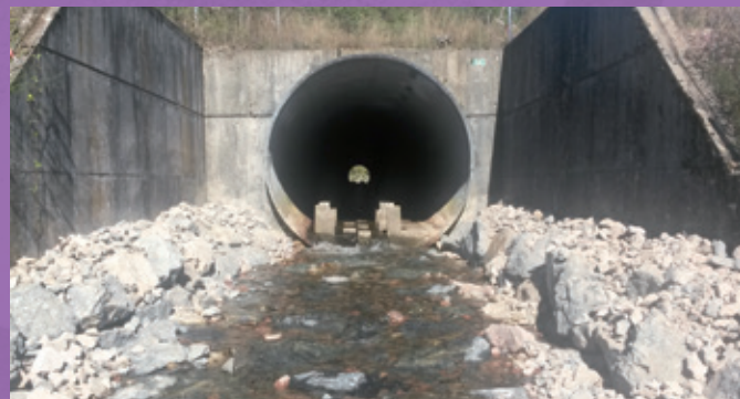
Figure 39 : Avant/Après: La fosse de dissipation a été comblée, la chute de 40 centimètres en sortie de buse supprimée, et des rugosités ont été ajoutées à l'intérieur de la buse pour influencer sur la vitesse d'écoulement. ©Photothèque VINCI Autoroutes
