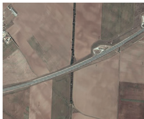
Figure 65 : Exemple de l'A83 (Deux-Sèvres) intersectant un corridor écologique évident (ancienne voie ferrée boisée) au milieu d'un paysage d'agriculture intensive. ©IGN, 2002.
