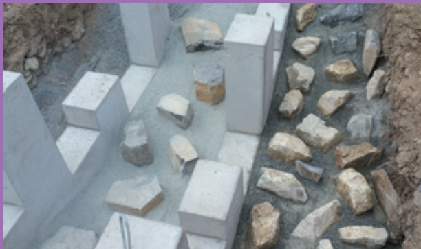
Figure 36 : Réalisation d'une planche test de la disposition des macro-rugosités disposées en quinconce et séparées par des blocs de roches saillants (+/- 10 centimètres). ©Photothèque VINCI Autoroutes
