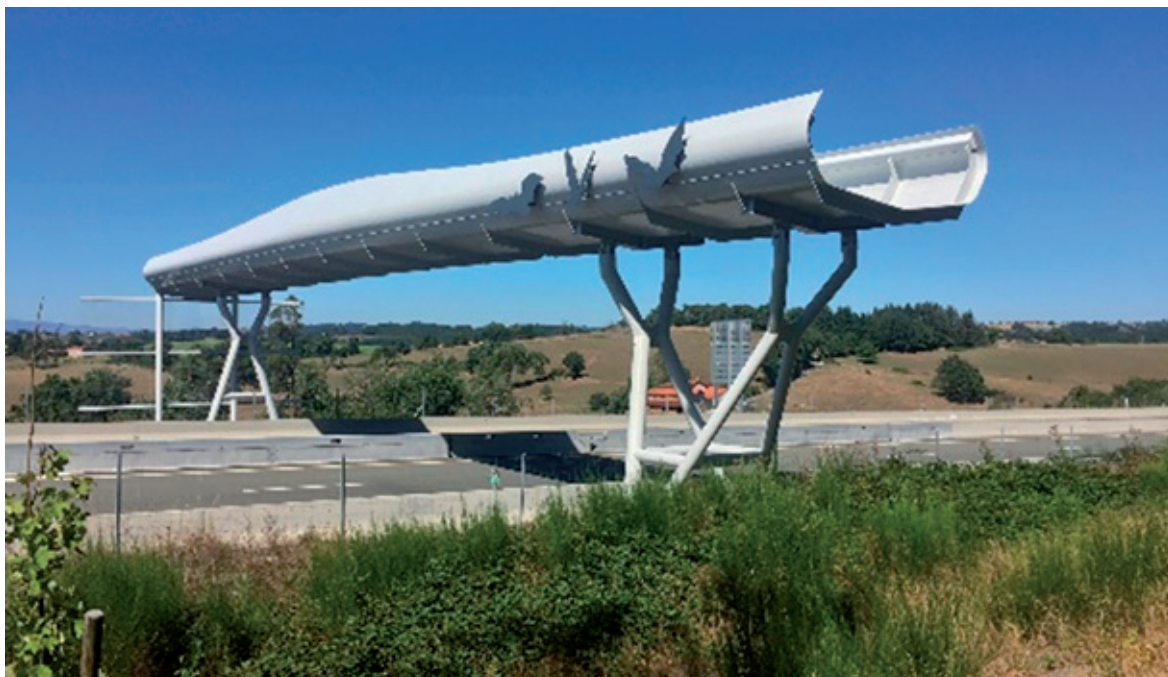
Figure 85 : Chiroduc (structure en berceau) de Moulin-Paris sur l'A89.
