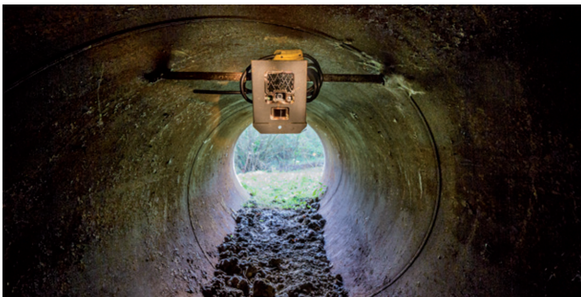
Figure 53 : Piège photographique installé dans un écoduc de 120 centimètres. ©Alexis Orseau/LPO France.
