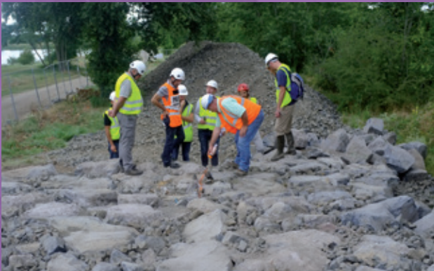
Figure 40 : Réalisation d'une planche de test pour la création de la rampe destinée au franchissement de la faune piscicole et aux canoës. ©Photothèque VINCI Autoroutes
