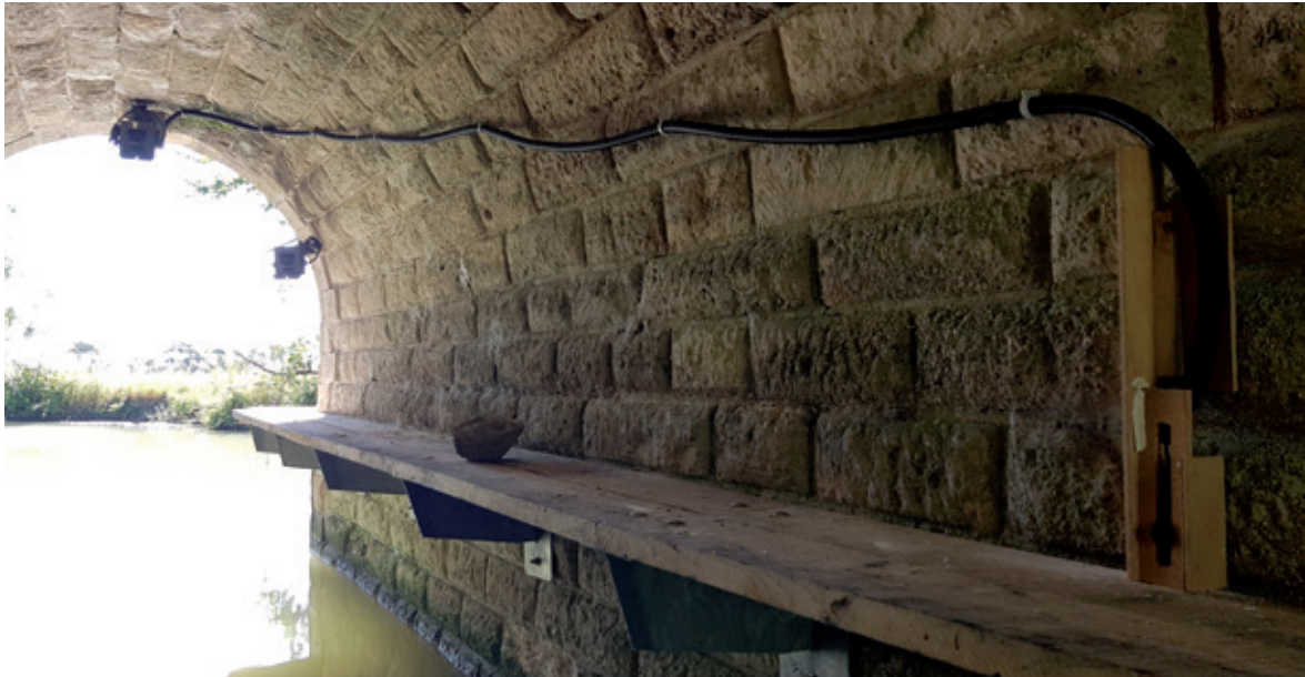
Figure 76 : Système de détection d'une barrière infrarouge déclenchant un piège photo sur l'encorbellement d'un ouvrage hydraulique routier. ©LIFE VISON/LPO France.
