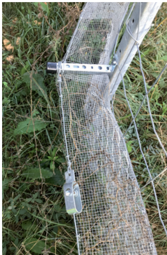
Figure 17 : Bavolet en maille fine en tête de grillage pour petite faune. Le dispositif le plus abouti possède un fil tendeur repris sur cornières. ©Cabinet X-AEQUO.
