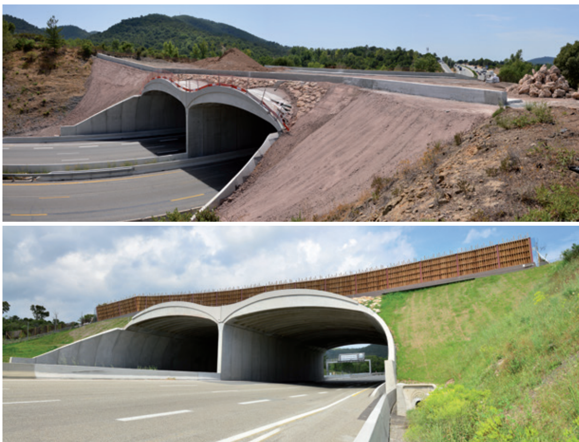
Figure 21 : La végétalisation par ensemencement des talus des ponts à doubles voûtes permet d'éviter le ravinement. ©M. MARTINI.
