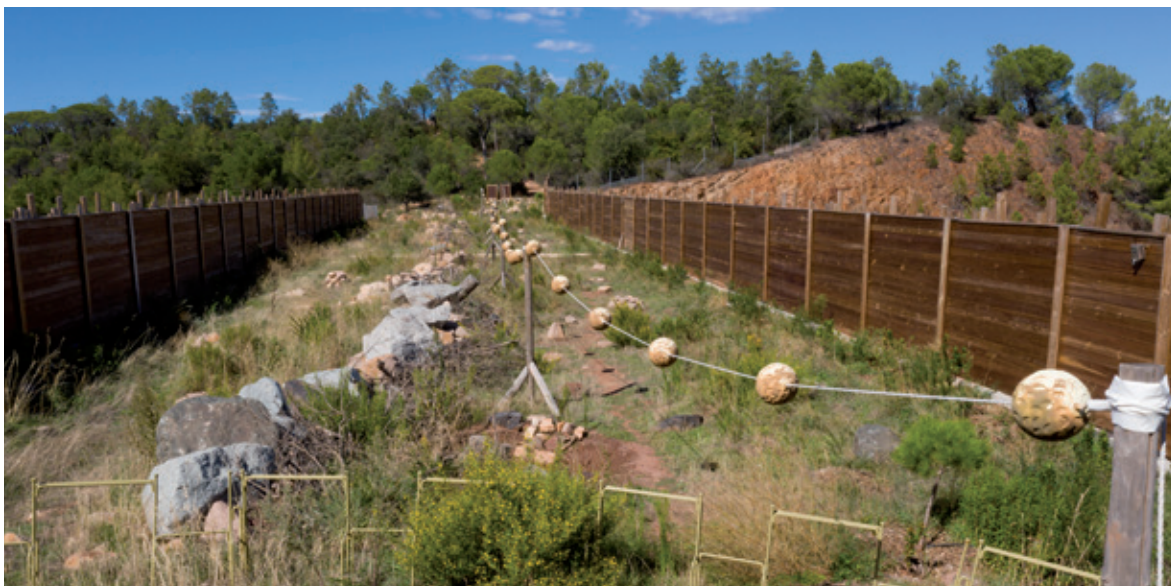
Figure 30 : Câbles et boules de guidage pour les chiroptères permettant de pallier le faible développement des haies sur l'ouvrage. ©VINCI Autoroutes et ©Cabinet X-AEQUO.
