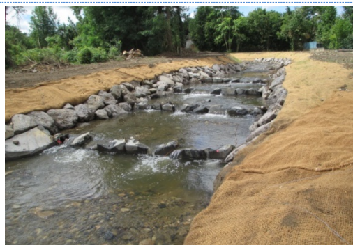
Les travaux d'arasement (© S.Maneval)
