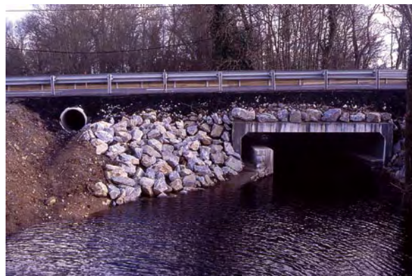
Photo 7 : aménagement du pont de la Duché (Loire-Atlantique) avec banquette prolongeant les berges et buse sèche – X, Moyon, PNR de Brière)
